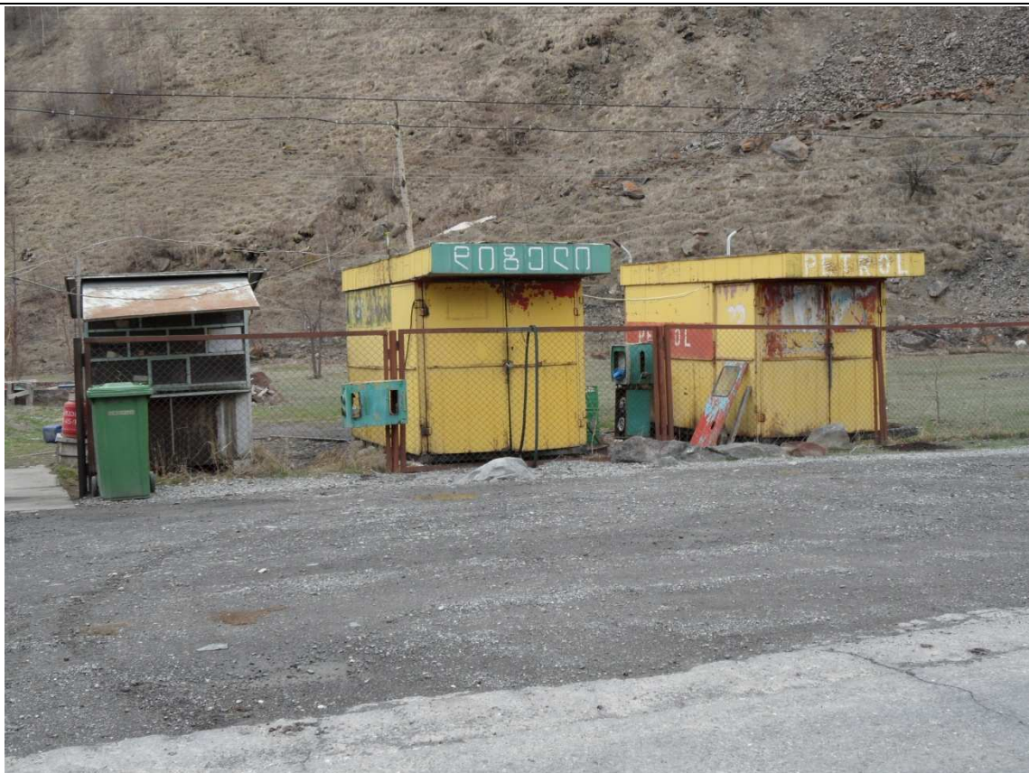
Gasolinera de Kazbegi Kazbegi, Georgia, Abril 2011 2011 © Javier Portillo
